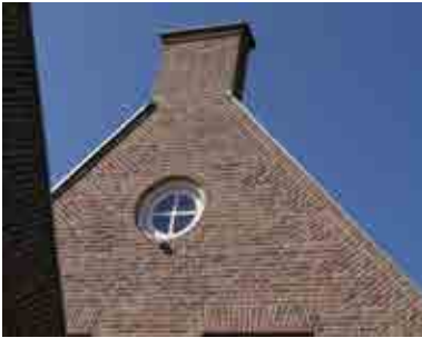
Schoorsteen als tuit van tuitgevel
