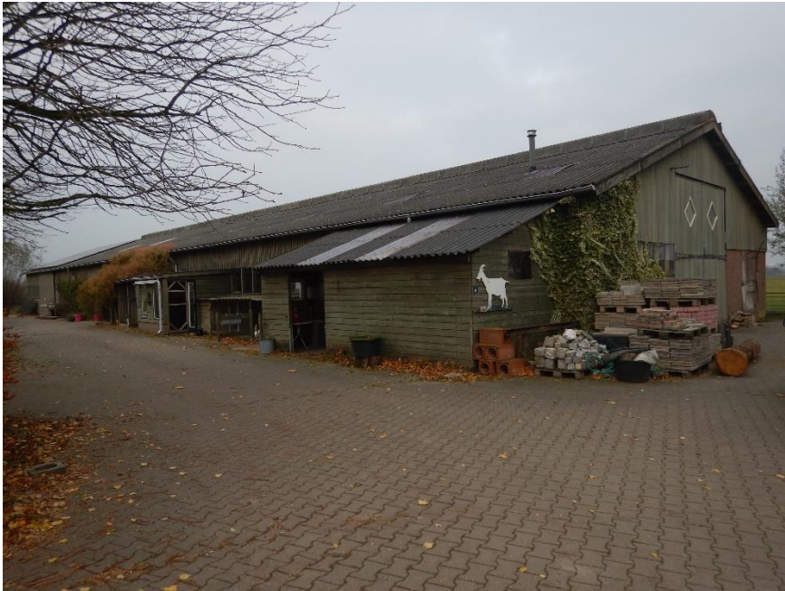
3 Gesloten schuur, deels van steen en hout met een dak van golfplaten.
