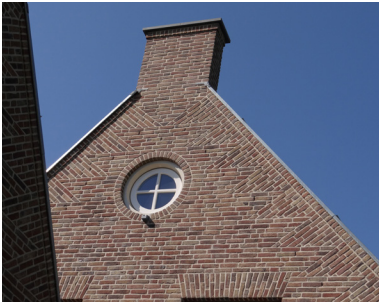
Schoorsteen als tuit van tuitgevel
