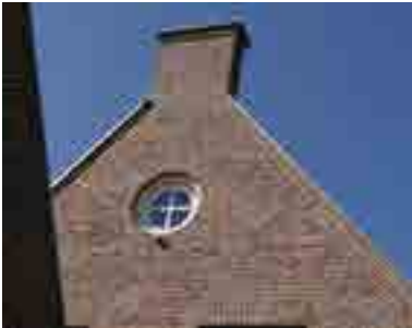
Schoorsteen als tuit van tuitgevel
