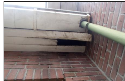
Figuur 13. Ruimte achter betimmering.
