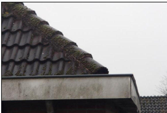
Figuur 9. Dakgoot met toegang tot dakbeschoot.
