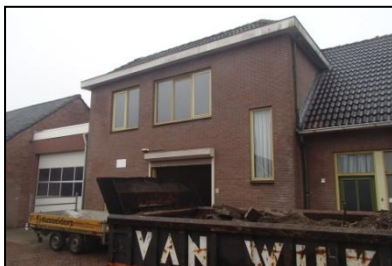
Figuur 3. Voorgevel oostkant.
