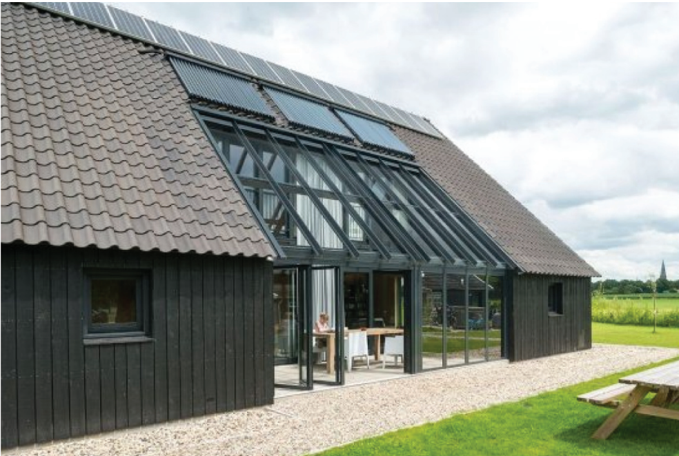
Glas doortrekken in het dakvlak zorgt voor extra verwarming van het huis
