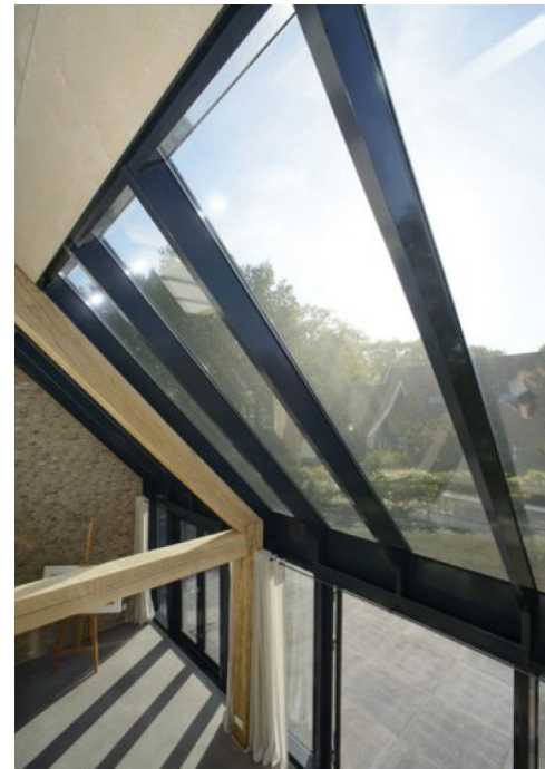
Lage goot, glazen gevel loopt door in het dakvlak
