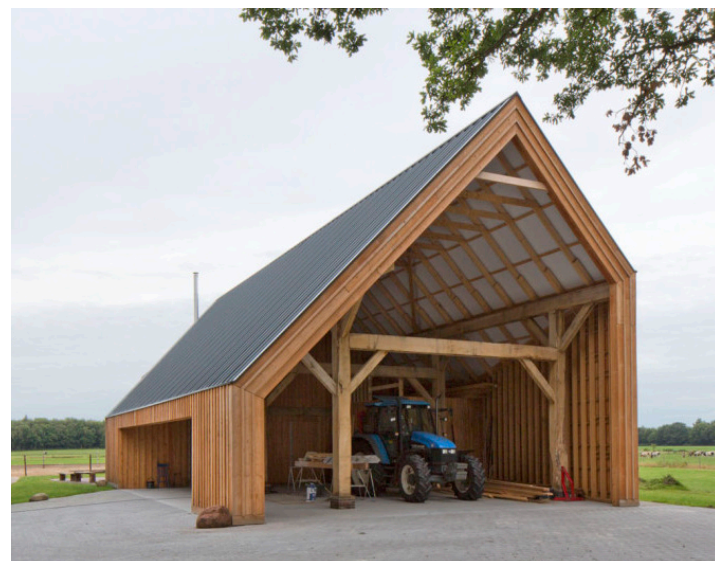
Asymetrische kap, schuurhuistype, zichtbare constructies, kapschuur
