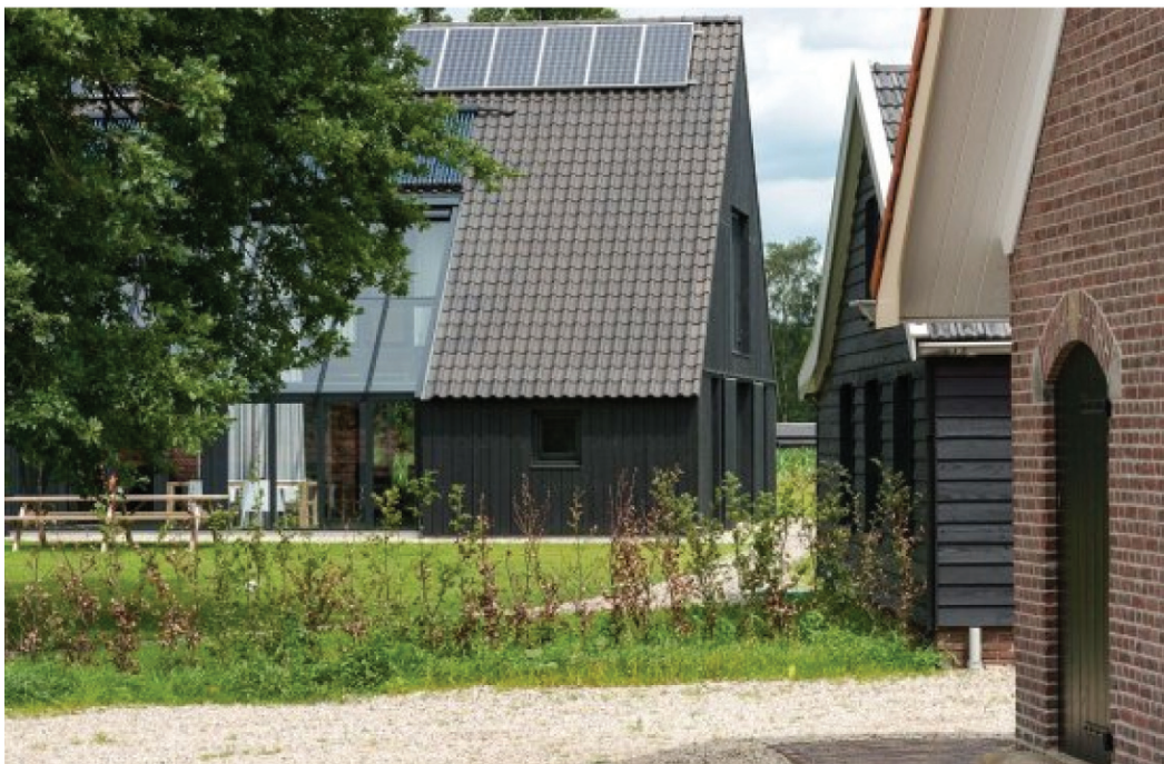
Lage goot, glazen gevel loopt door in het dakvlak
