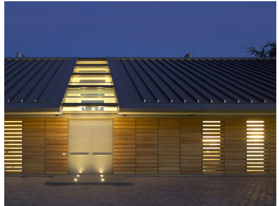
'Lichtstraat', twee dakvlakken scheiding woning en bijgebouw
