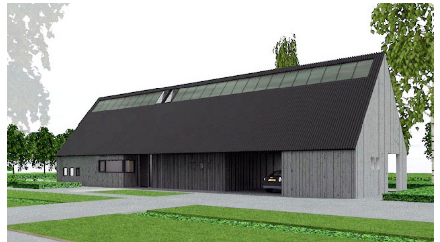
Weinig gevelopeningen aan de erfzijde
