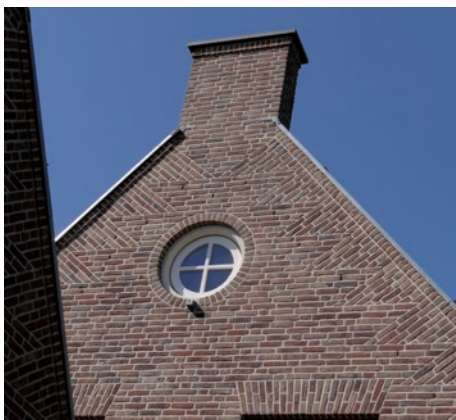
Schoorsteen als tuit van tuitgevel
