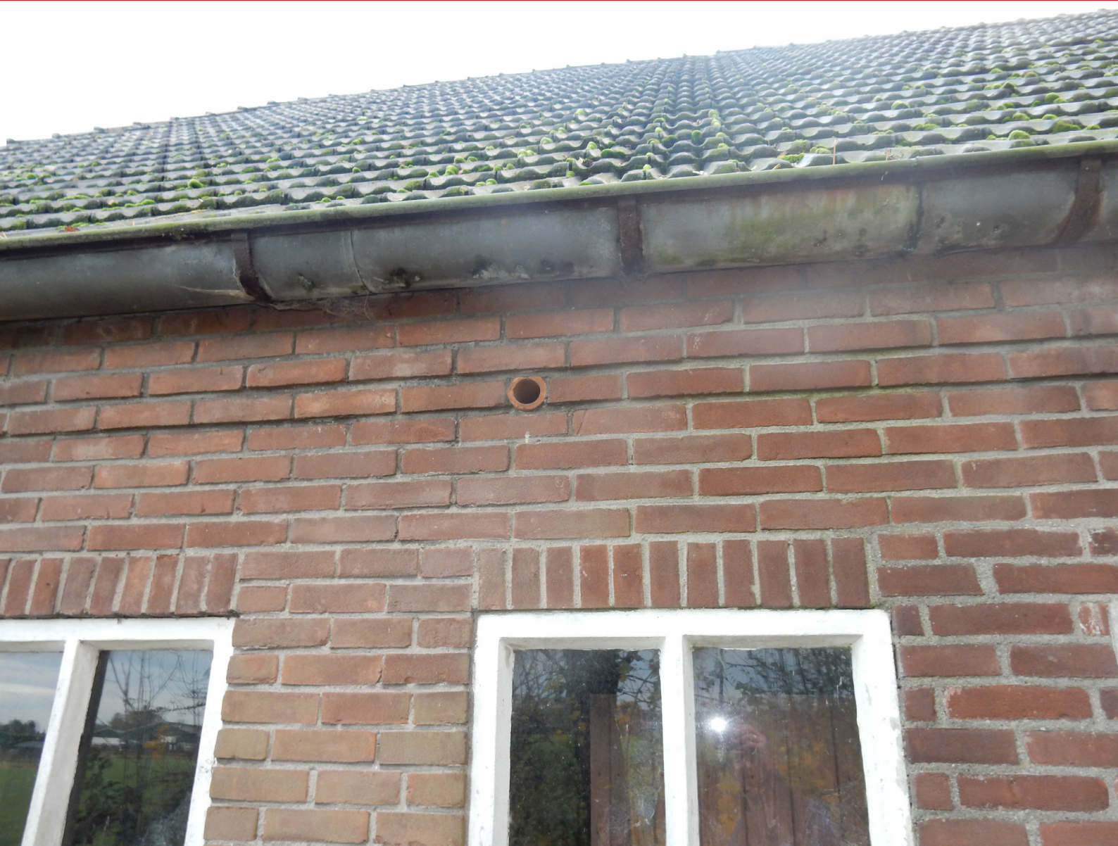
Beeldimpressie woonboerderij: open ventilatiegaten die doorlopen naar binnen (stal)
