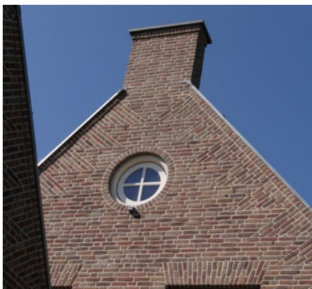
Schoorsteen als tuit van tuitgevel
