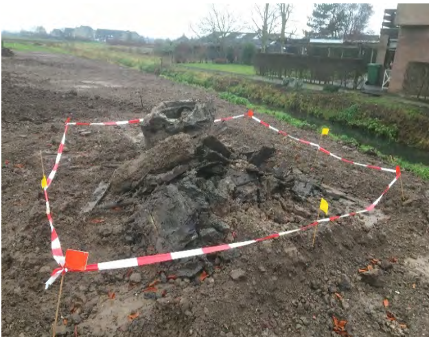
Figuur 5. Aangetroffen vervuiling en asbest.
