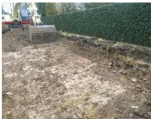
Figuur 7. Gecontroleerd ontgraven.
