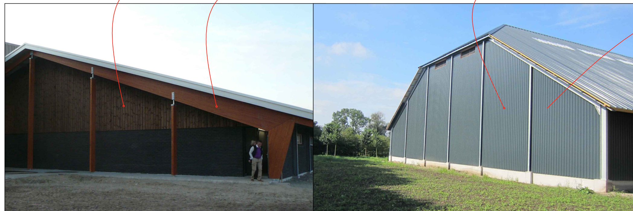
houten spant en houten gevelbekleding
