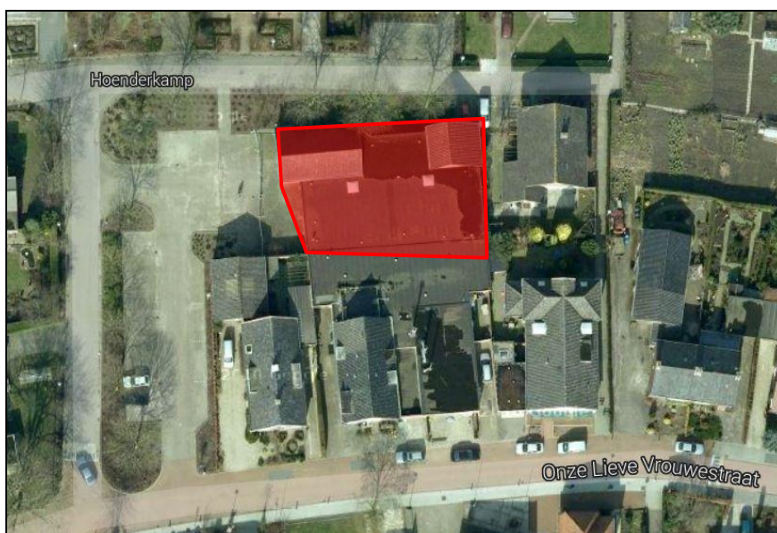
Figuur 2. Het te slopen deel van de voormalige supermarkt. (bron: www.googlemaps.com ).
