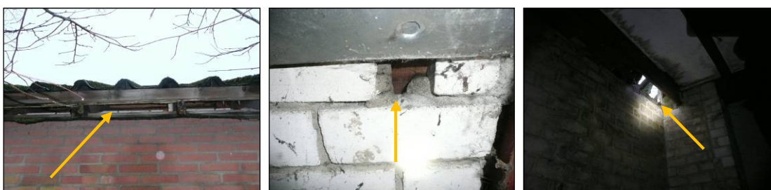
Figuur 7. Mogelijke toegangen tot verblijfplaatsen van vleermuizen, onder het dak en in de spouwmuur. Ook geven diverse gaten direct toegang tot de binnenruimte.
