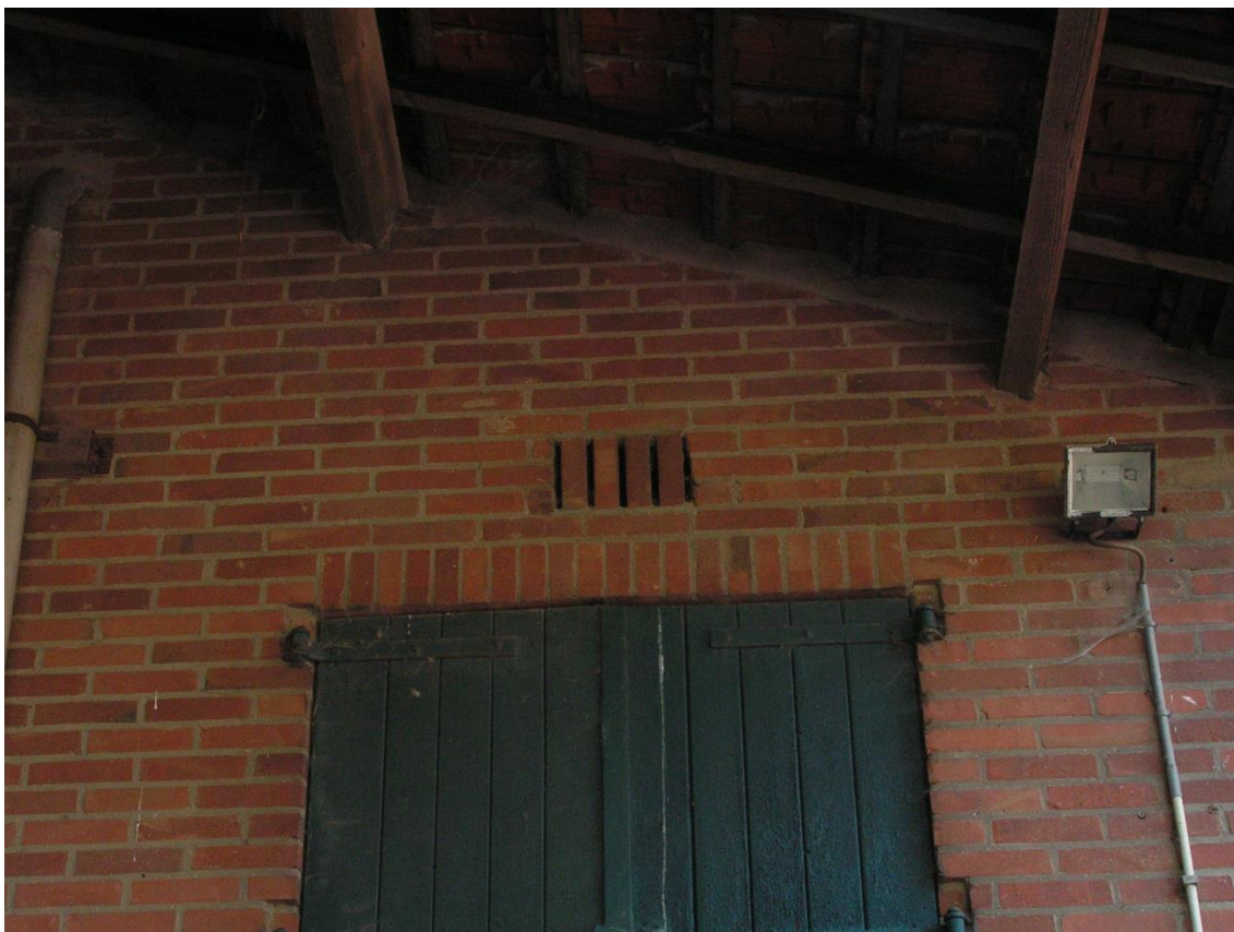
Figuur 6. In een van de te slopen schuren bevindt zich een spouwmuur welke toegang kan bieden aan vleermuizen.
