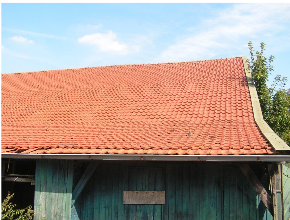
Figuur 2. Een van de te slopen schuren met dakpannen en houten betimmering. Mede door de staat biedt deze toegang voor huismussen en vleermuizen.
