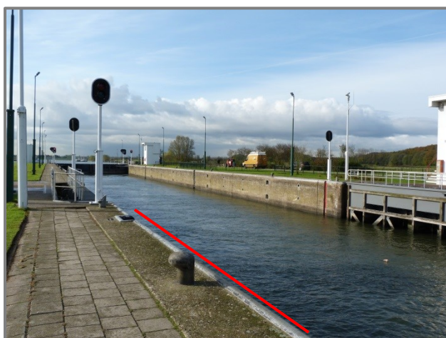
Kademuren in Driel waar de ringslang is aangetroffen.
