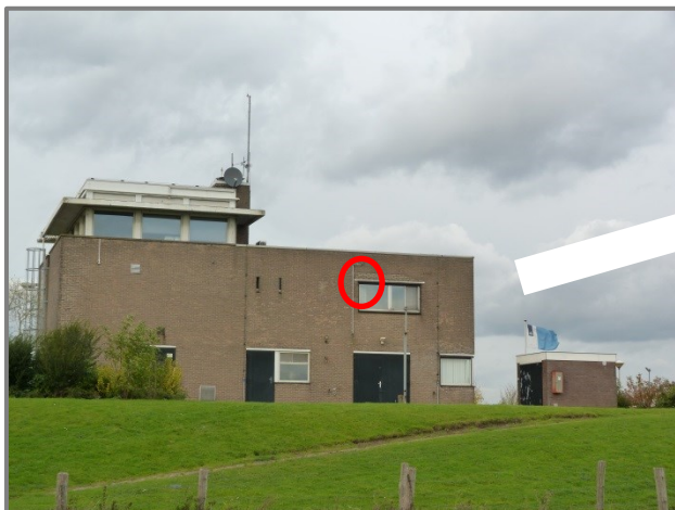
Achterzijde bedieningsgebouw met invliegopening.
