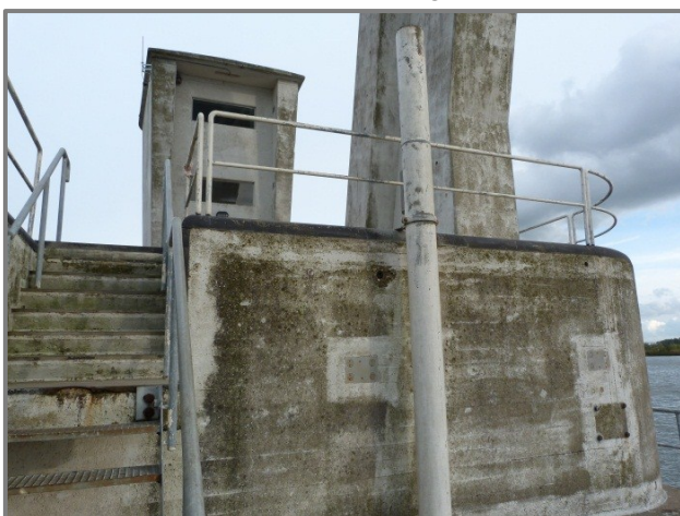
Staat van de betonconstructie in Amerongen
