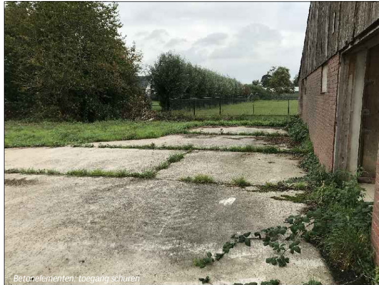
Betonelementen: toegang schuren
