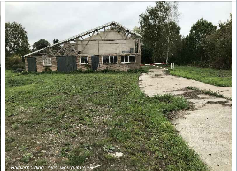
Halfverharding - puin: werkruimte erf
