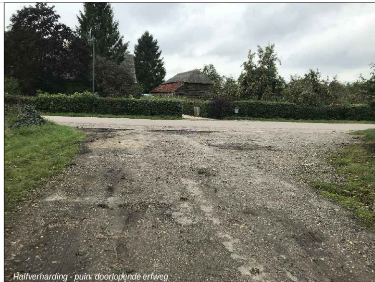
Halfverharding - puin: doorlopende erfsweg
