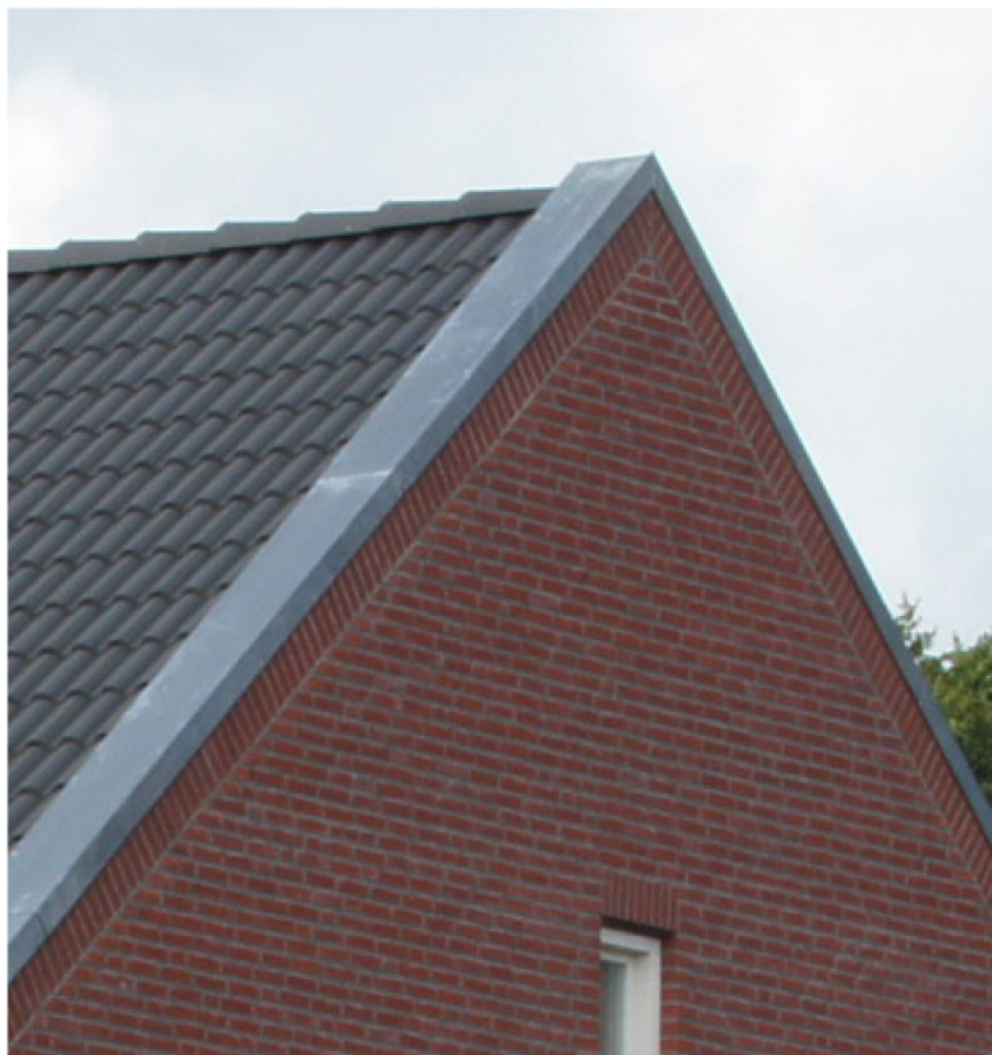
Eenvoudig metselwerkvolume met sobere detaillering
