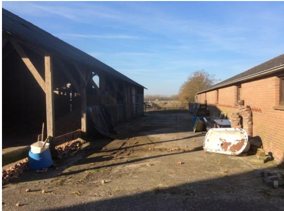
Figuur 8: Overzichtsfoto bebouwing
