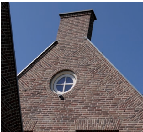
Schoorsteen als tuit van tuitgevel
