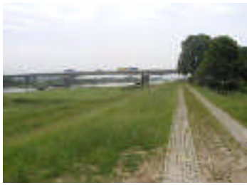
Brug van de A50.
