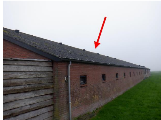
Foto 16 | Foto voor bron Golfplaat dakbedekking
