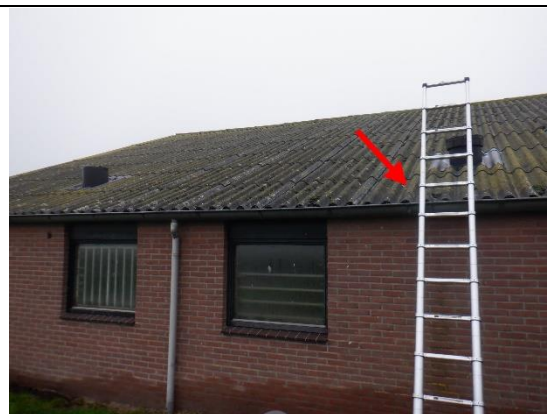
Foto 14 | Foto voor bron Golfplaat dakbedekking
