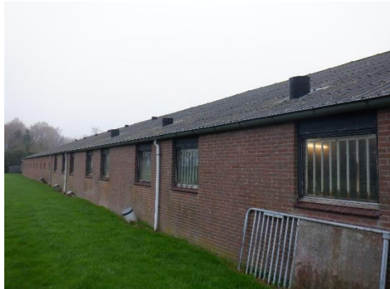
Foto 15 | Foto voor bron Golfplaat dakbedekking
