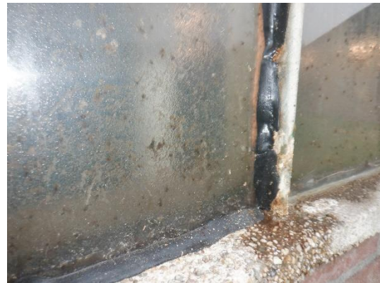
Foto raamafwerking niet verdacht
