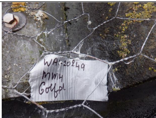
Foto 13 | Foto voor bron Golfplaat dakbedekking
