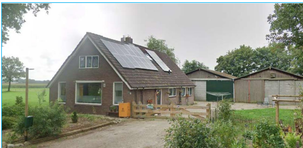
Fig. 1.2: Een weergave van het perceel en bebouwing binnen het plangebied
