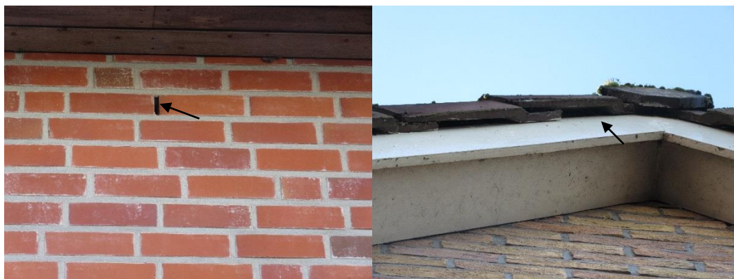
Figuur 5.2. Openingen in de muur (spouwmuurgaten) en achter de pannen, mogelijk geschikt voor vleermuizen (links) het huidige winkelpand van de Aldi (rechts) het woonhuis.
