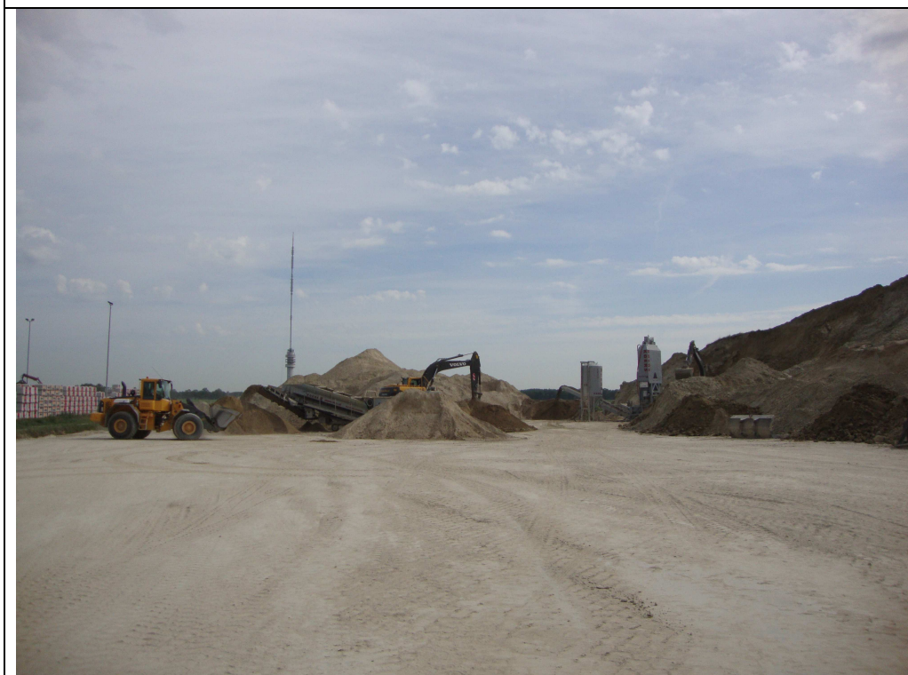
Figuur III.8: Rechts: Mengen leem met ongeblust kalk op leemdepot Links: Sterrenzeef
