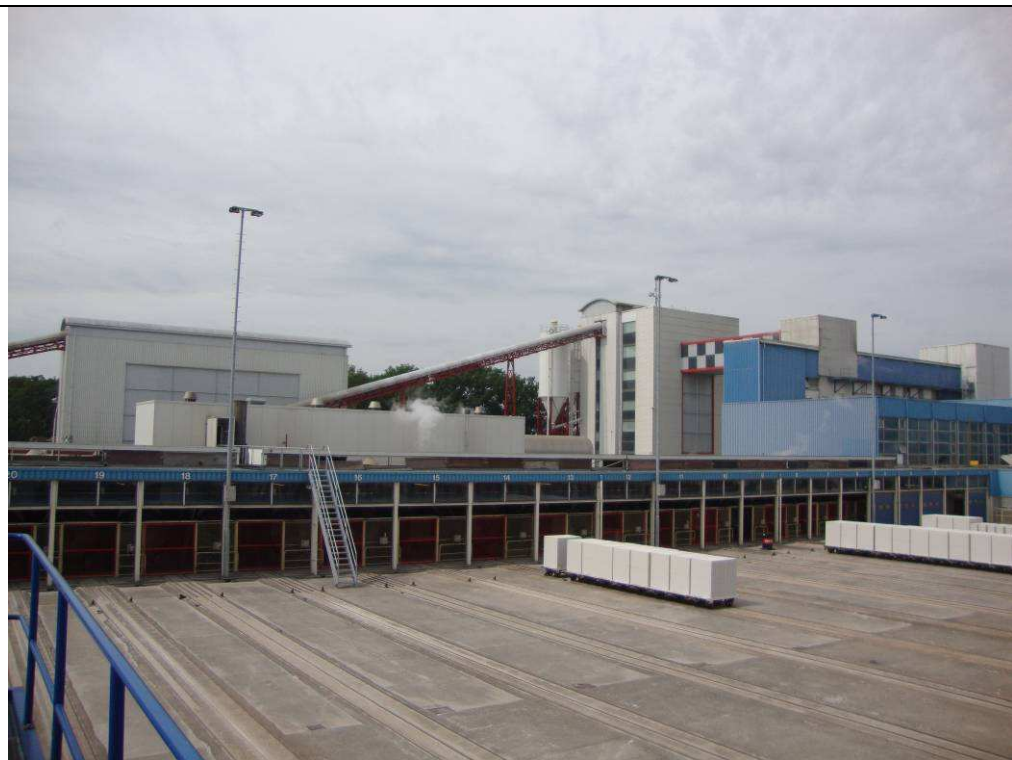
Figuur III.5: Zandsilogebouw, mengerij en productiehal gezien vanaf de inpakhal
