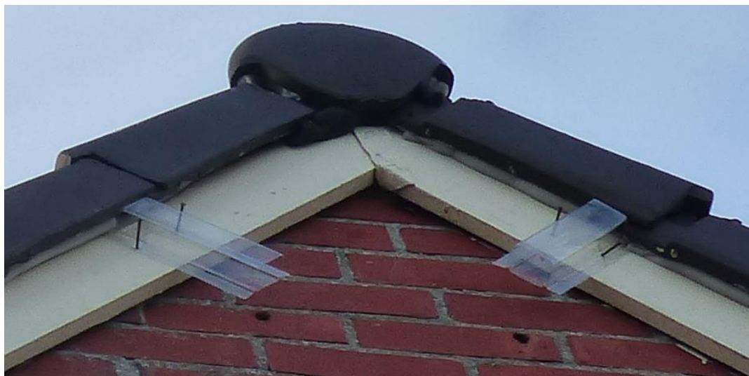
Foto 3 Een voorbeeld van geplaatste exclusion flaps bij kantpannen, waarvan de overige kieren zijn afgezet met vulschuim.
