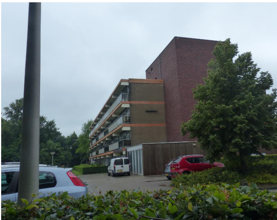
Foto 13 Opgehangen huismusnestkasten aan de Torenlaan 109-321. In de omgeving zijn bomen en struiken aanwezig.
