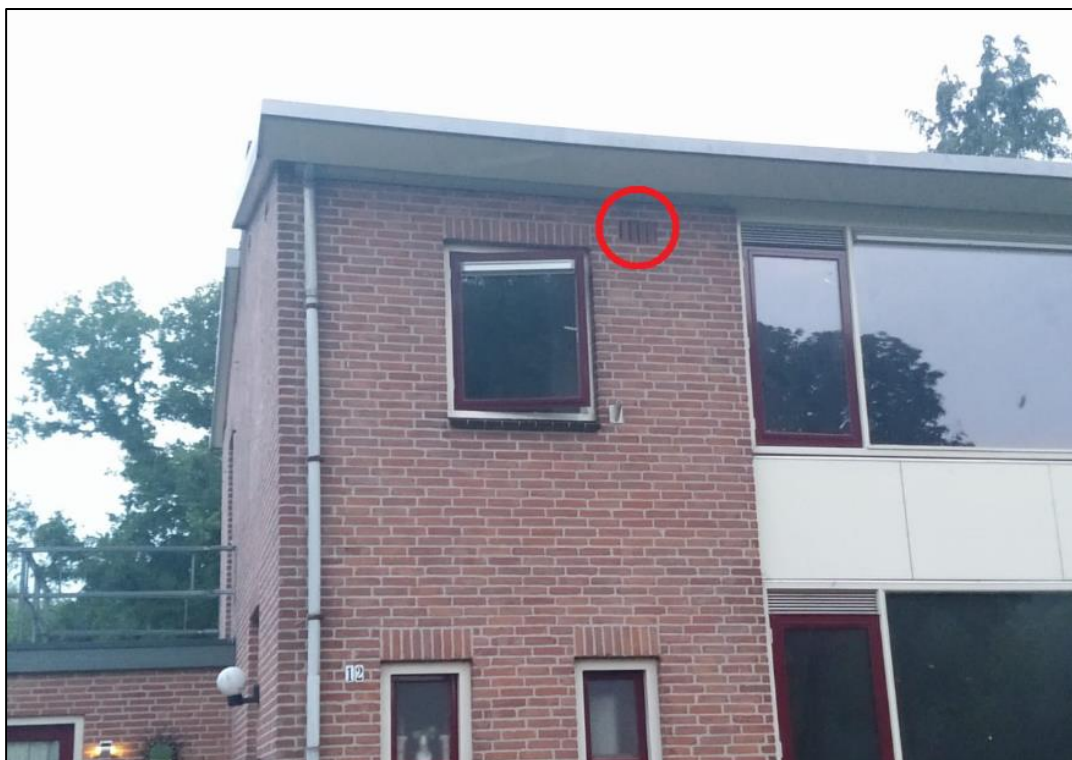
Figuur 42 Zomerverblijf gewone dwergvleermuis Burg Gratamaplein 12 Veenoord
