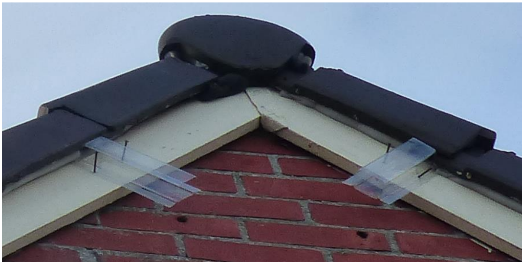
Foto 9 Een voorbeeld van geplaatste exclusion flaps bij kantpannen, waarvan de overige kieren zijn afgezet met vulschuim.
