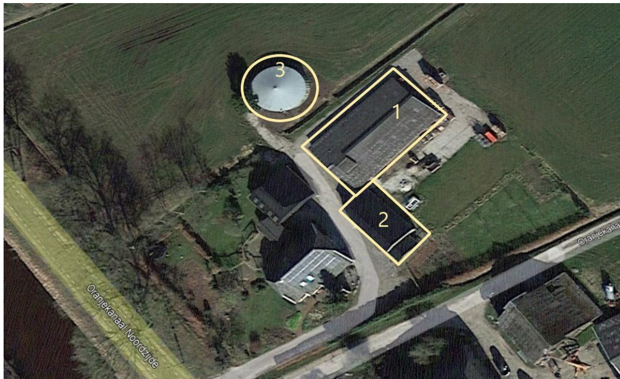
Figuur 2: Ligging van de planlocatie. Gebouwen in gele kaders worden afgebroken. 1: voormalige ligboxenstal, 2: kapschuur, 3: oude mestsiilo. Bron: Google Earth.
