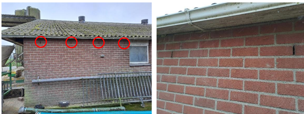
Impressie van de open stootvoegen in de buitengevel van de varkensstallen.
