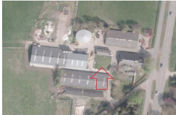
figuur 4: deel van de loods is afgebroken
