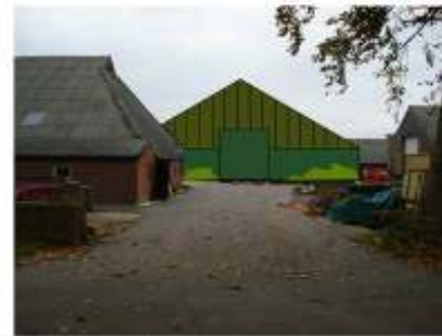
bestaande oprit met straks zicht op nieuwe schuur
