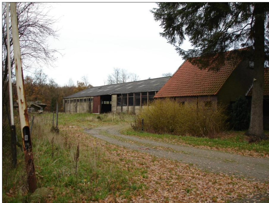
De inmiddels gesloopte voormalige bedrijfsbebouwing
