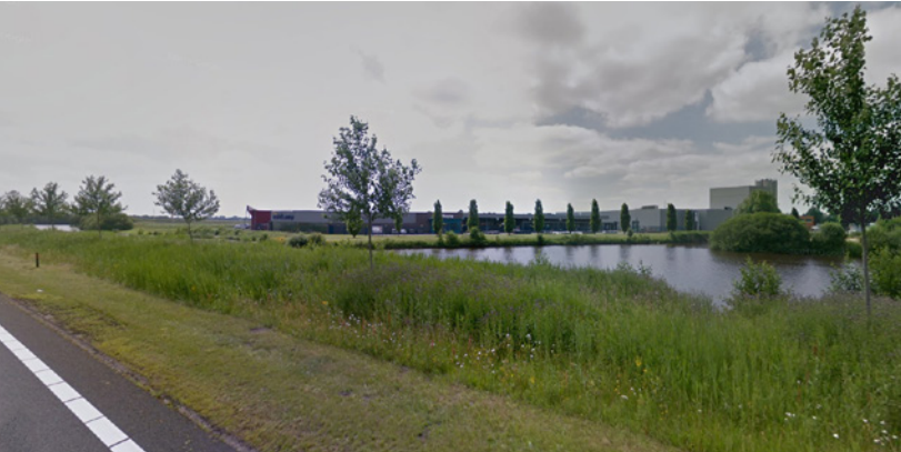
N33 bij Veendam: een voorbeeld waar door water en groen afstand en kwaliteit is gecreëerd tussen de snelweg en het bedrijventerrein
