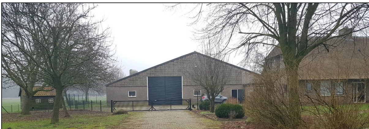
Figuur 2.2. De boerderij in het plangebied (gebouw rechts) biedt gleuven welke potentieel geschikt zijn voor het voorkomen van verblijfplaatsen van vleermuizen, bij bijvoorbeeld de schoorsteen.
