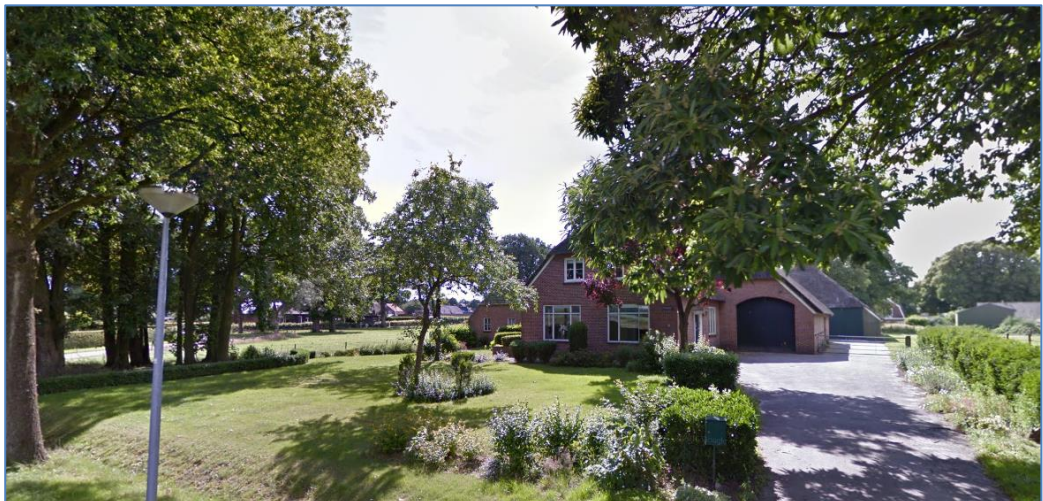
Figuur 2.3: De bestaande woning en bijbehorende bouwwerken op het perceel Middendorp 5 te Hooghalen.
