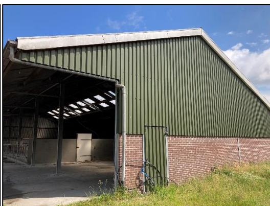
Figuur 2.9 (links): De oostzijde van de jongveestal bestaat uit een gemetselde muur met damwand; Figuur 2.10 (rechts): De zuidzijde van de stal.
