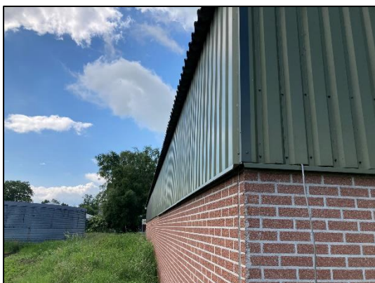
Figuur 2.9 (links): De oostzijde van de jongveestal bestaat uit een gemetselde muur met damwand; Figuur 2.10 (rechts): De zuidzijde van de stal.
