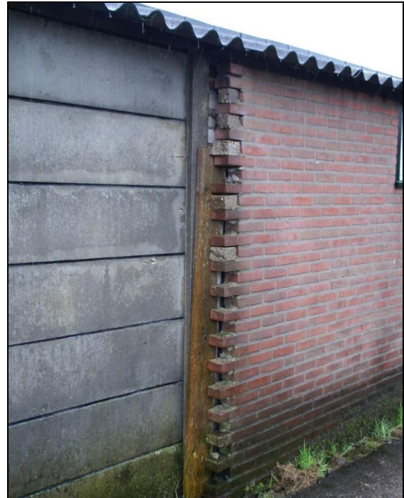
Foto 5. Muren van de jongveestalling, deels met en deels zonder spouw.
