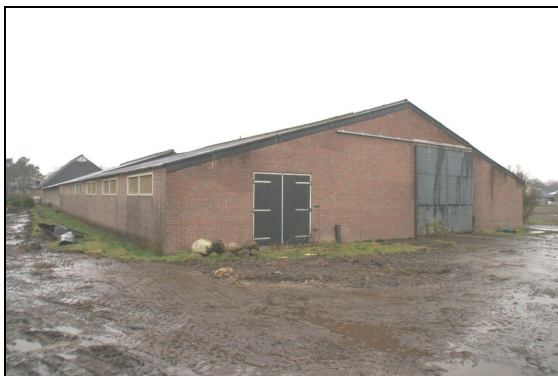
Foto 1. Te slopen jongveestalling.
