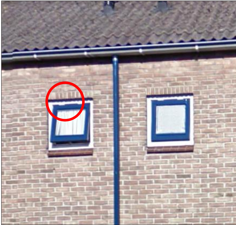
Figuur 7. Verblijfplaats tussen muur en raamkozijn nr. 19
