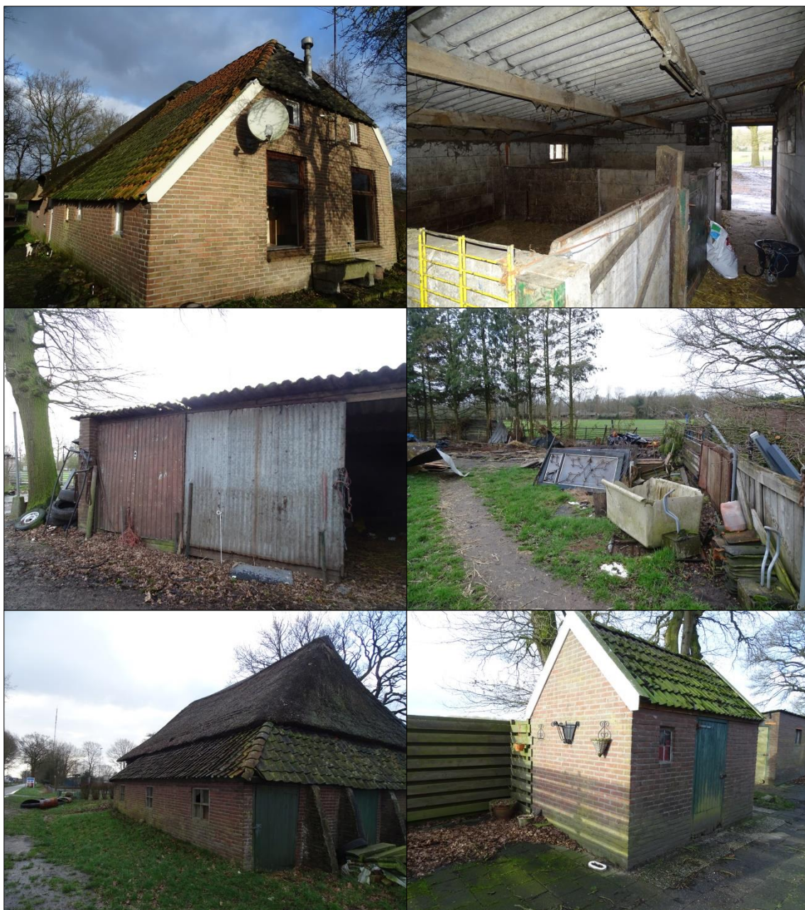
Foto's 1 t/m 6. Impressie van de te slopen bebouwing op 12 februari 2020.
