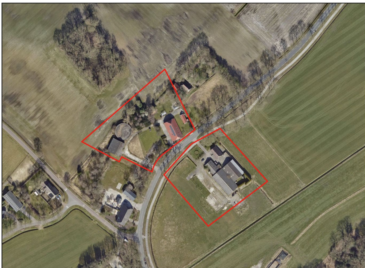
Afbeelding 3.1 Luchtfoto plangebied (Bron: PDOK, bewerkt)
