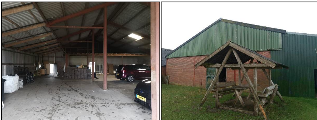
Figuur 2.7 (links): Binnenaanzicht van de aan te passen schuur, aangegeven met een B in figuur 2.2; Figuur 2.8 (rechts): Impressie van de te behouden gevel van de aan te passen schuur..
