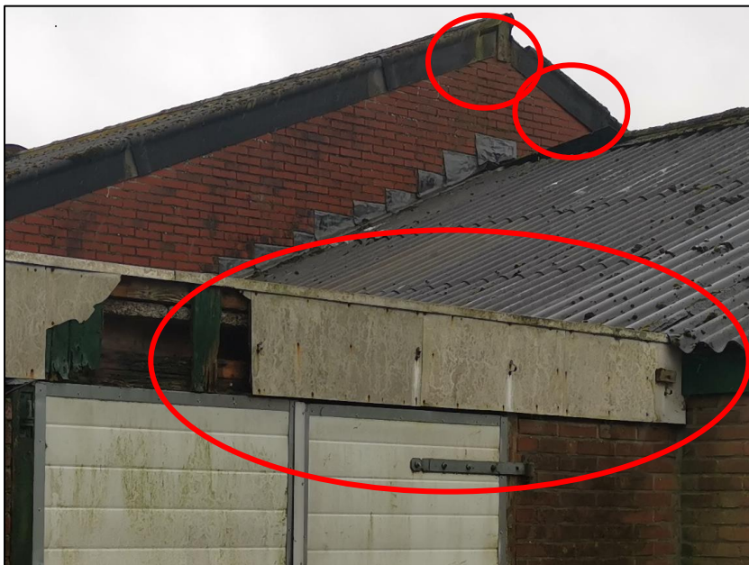
Figuur 6.4: Voorbeelden van mogelijkheden voor vleermuizen om zich toegang tot een holle ruimte te verschaffen aan de buitenzijde van de te slopen schuur.
