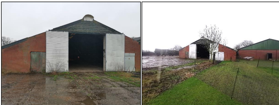
Figuur 2.3: Buitenaanzicht van de te slopen schuur, aangegeven met A in figuur 2.2.
