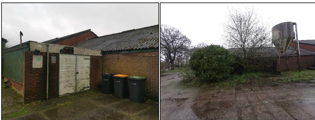
Figuur 2.4 (links): Buitenaanzicht van de te slopen schuur, aangegeven met een A in figuur 2.2; Figuur 2.5 (rechts): Opgaande vegetatie aan de zuidwestelijke zijde van de te slopen schuur
