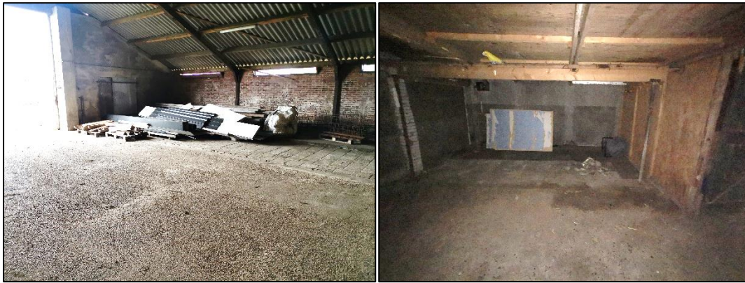
Figuur 2.6: Binnenaanzicht van de te slopen schuur, met enkele materialenhopen en oude stallen..
