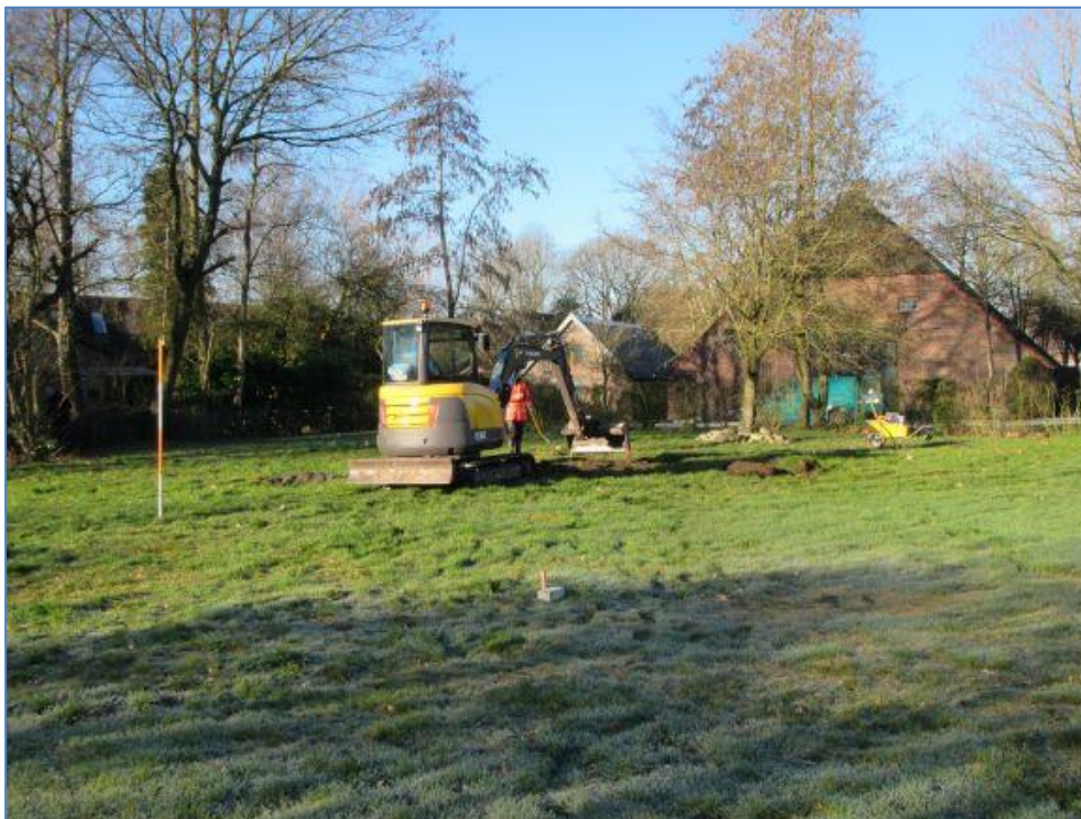
Afbeelding 3. Foto van het onderzoeksgebied bij de aanleg van de proefsleuf. De foto is gericht naar het noordwesten.
