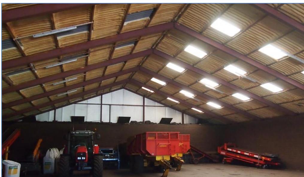
Fig. 1.3.: Opslagruimte in de bestaande schuur
