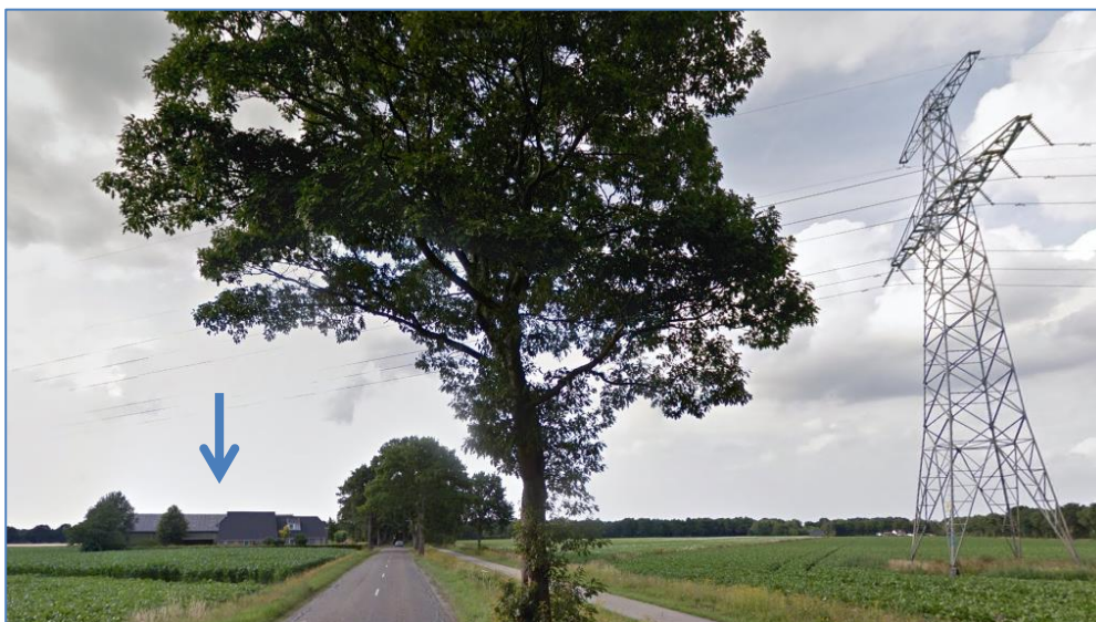
Fig. 4.4.: Hoogspanningsmast ter plaatse van het plangebied (blauwe pijl)
