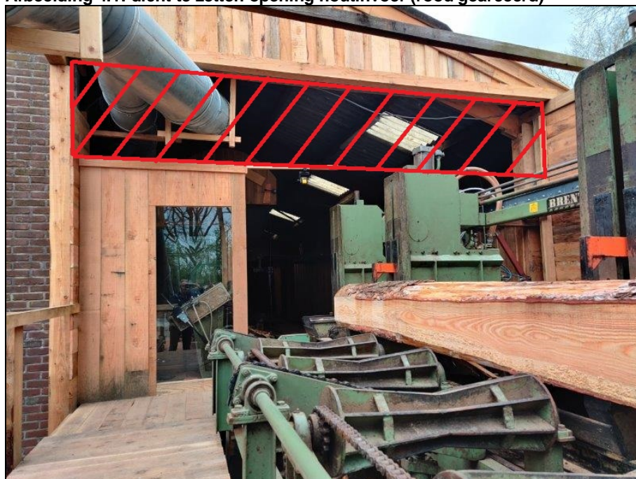
Afbeelding 4.1: dicht te zetten opening houtinvoer (rood gearceerd)
