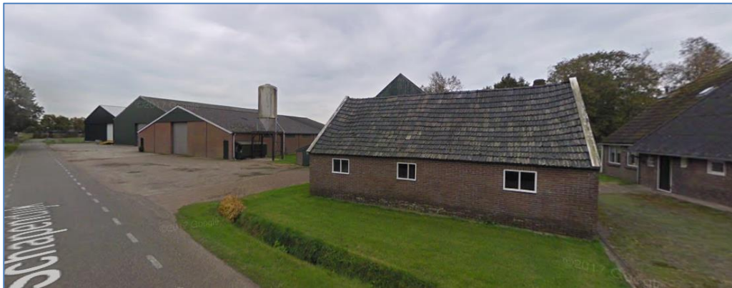
Fig. 1.2: Het bedrijf gezien vanaf de Schapendijk, met zicht op de bestaande bebouwing / schuren
