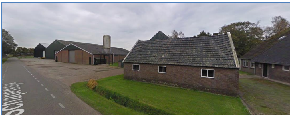
Fig. 1.2: Het bedrijf gezien vanaf de Schapendijk, met zicht op de bestaande bebouwing / schuren
