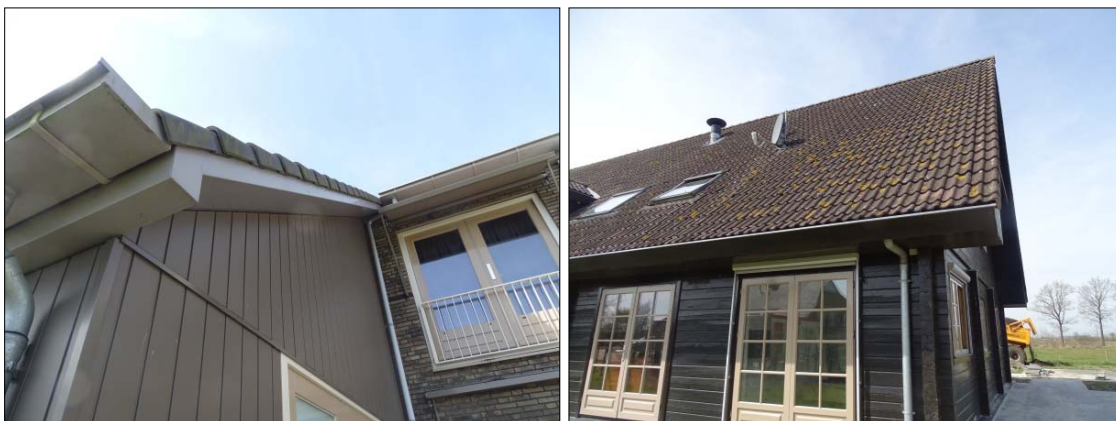
Foto's 7 en 8. Links de dakrand van het middenstuk van het hoofdgebouw. Rechts het dak van de Finse woning
