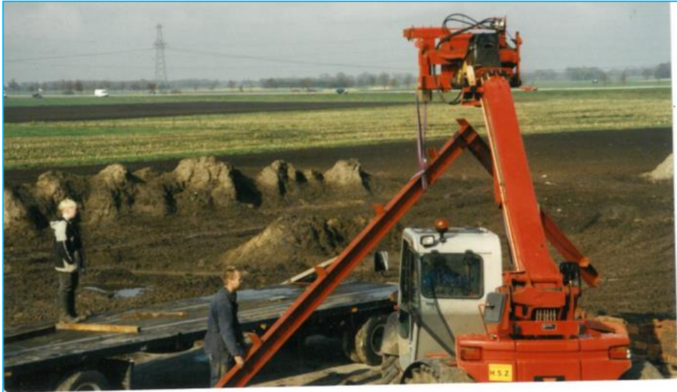
Foto 2: plaatsing van spanten met op achtergrond afgegraven grond en reeds deels nieuw opgebrachte zwarte grond.
