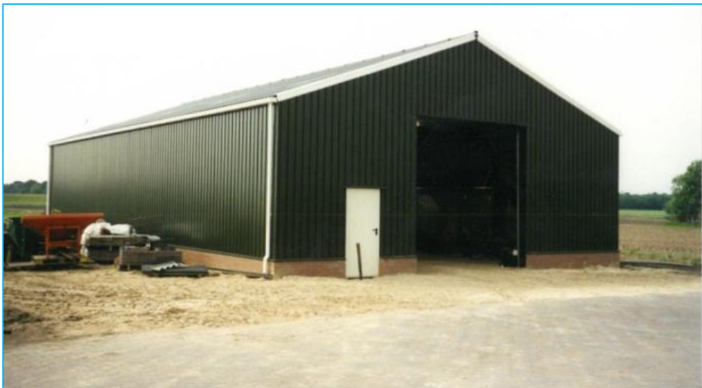
Foto 3: Geplaatste loods met gele zand in en rondom de nieuwe loods
