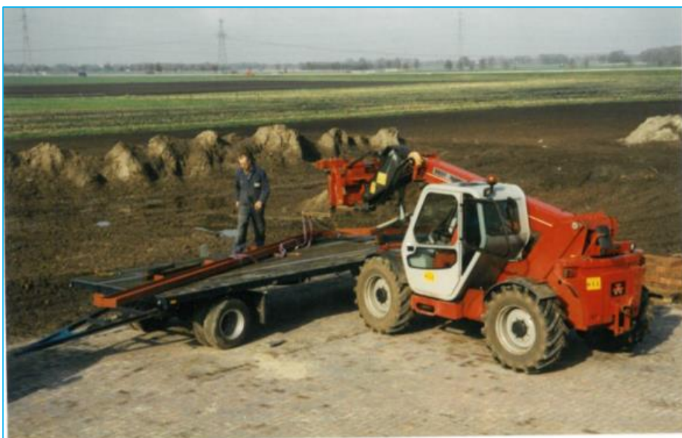
Foto 1: Levering van spanten met afgegraven grond op achtergrond
