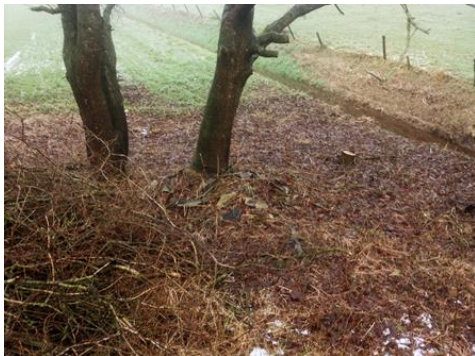
Foto 1: Situering asbest(-verdacht) materiaal op maaiveld
