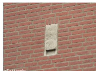
Figuur 2: Schwegler inbouwkast (geschikt voor kleine groepjes of solitaire dwergvleermuizen)
