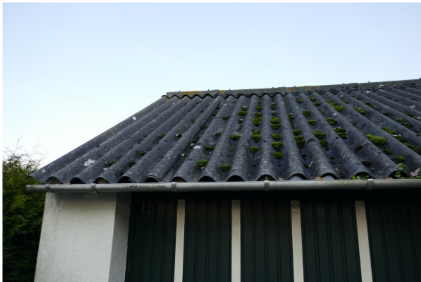
De schuur/garage is belegd met golfplaat.
